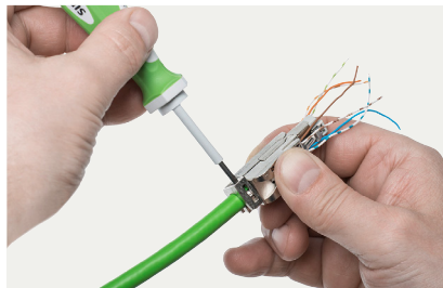
Gehäuse mit Schraubendreher verriegeln
