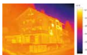
Wärmebild ohne testo ScaleAssist
