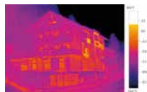
Wärmebild mit testo ScaleAssist
