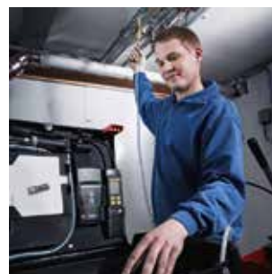
Trink- und Abwasserleitungsprüfung mit Hochdrucksonde bis 25 bar
