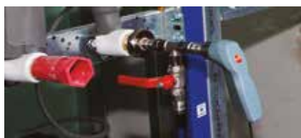
Belastungsprüfung mit Wasser oder Druck > 1 bar mit Hochdrucksonde und -anschluss
