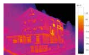
Wärmebild mit testo ScaleAssist
