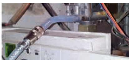
Gebrauchsfähigkeitsprüfung mit dem Adapter über die Gastherme
