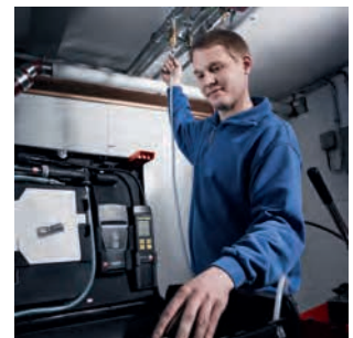
Trink- und Abwasserleitungsprüfung mit Hochdrucksonde bis 25 bar
