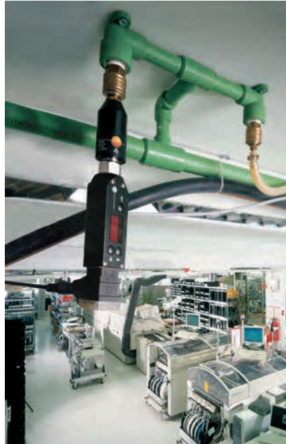
Bei kritischen Anwendungen überwacht der testo 6740 die Druckluftfeuchte direkt vor dem Verbraucher – z.B. in der Elektronikfertigung.
