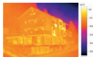
Wärmebild ohne testo ScaleAssist
