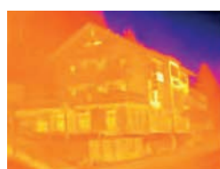
Wärmebild ohne testo ScaleAssist
