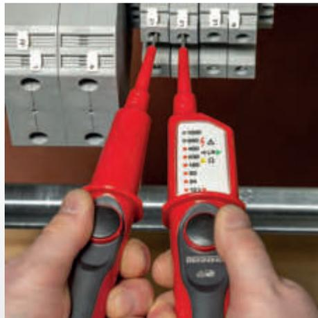
Drehfeldprüfung an den Ausgangsklemmen einer USV
