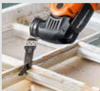
Restaurieren alter Fenster.
