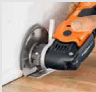
Dehnfugen lassen sich hervorragend nachschneiden.
