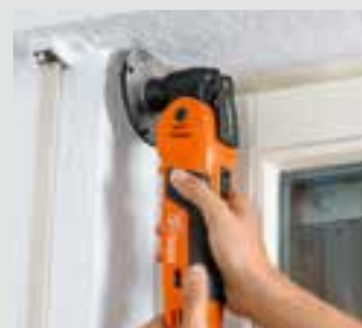
Rolladenkasten-Abdeckungen auftrennen.
