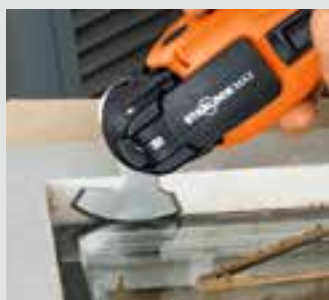
Kittbettverlegte Isolierglasscheiben austrennen.
