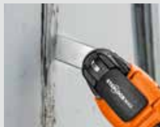
Entfernen von elastischen Fugendichtstoffen im Hoch- und Tiefbau.
