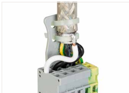
Mittels Kabelbinder den Schirmleiter und die Schirmübergabe (790-350) an der Zugentlastungsplatte befestigen.
