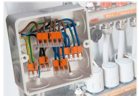
Verdrahtung feindrätiger Leiter in Installationsdosen
