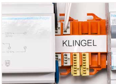
Anwendung für eine Hausklingelanlage – Befestigung auf Tragschiene 35
