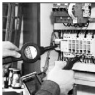
Spannungsfreiheit feststellen
