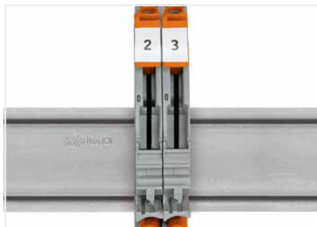
Kurzschluss für Stromwandler-Prüfschaltungen vorbereiten.
