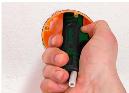
Abmanteln des Kabelmantels
