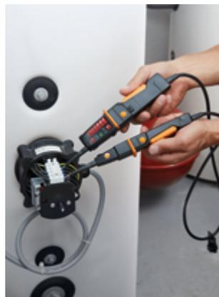
Spannungsmessung an einem Heizlastspeicher.
