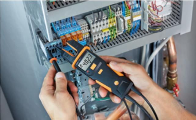
Spannungsprüfung an einer Wärmepumpe mit **testo 755**.
