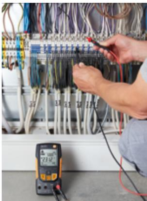
Spannungsprüfung am Schalt-schrank.
