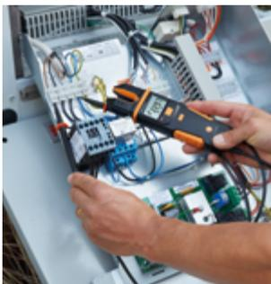
Spannungsmessung an einem Verdichter.
