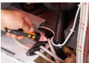
Erstprüfung der Spannungsversorgung an einem Verdichter.
