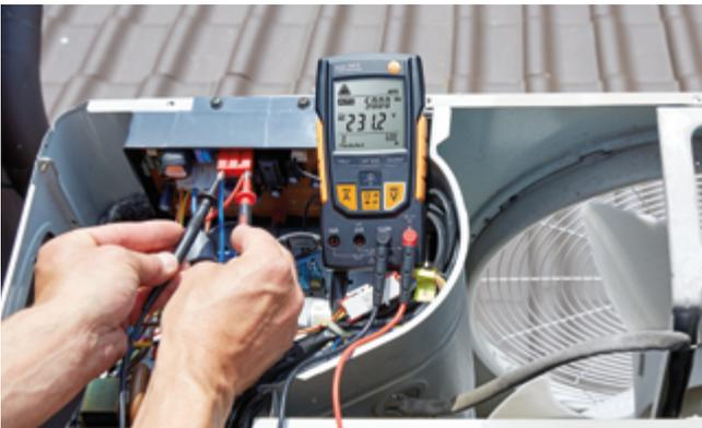
Spannungsmessung an einer Kälte-Außeneinheit mit **testo 760**.
