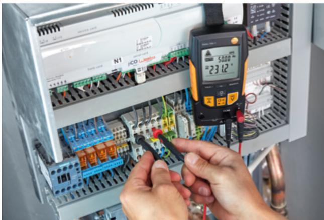
Spannungsprüfung am Schaltfeld einer Wärmepumpe.
