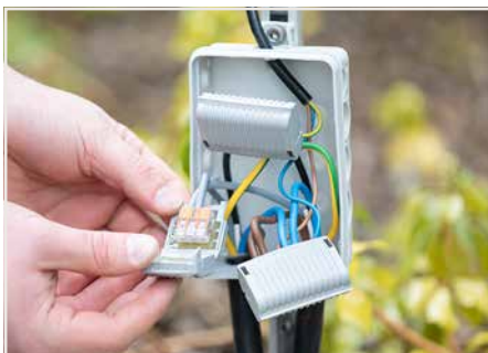
Anschluss einer Pollerleuchte
