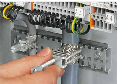
Aufstecken eines weiteren Schirmklemmbügel
