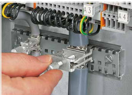
Festdrehen/Lösen eines Schirmklemmbügel
