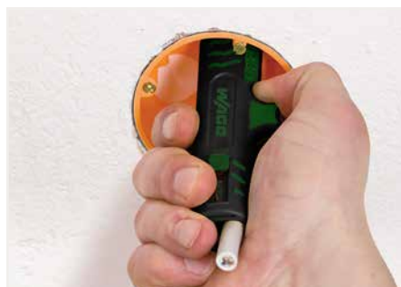
Abmanteln des Kabelmantels
