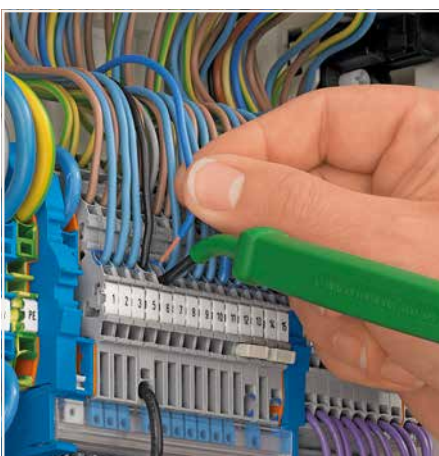
Öffnen der Klemmstelle mit Betätigungswerkzeug
