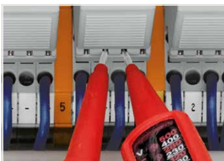
Funktionsprüfung an berührungsgeschützten Tipp-prüfkontakten
