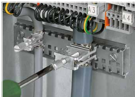
Nach dem Aufstecken die Rändelschraube festdrehen. Empfohlenes Anzugsmoment der Schraube 0,5 Nm
