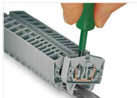
Die Klemme von der Tragschiene hebeln.
