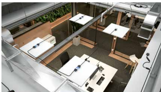
In der Decke
