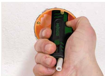
Abmanteln des Kabelmantels
