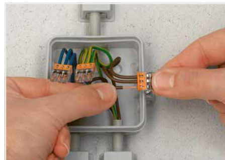
Anschließen: Abisolierten eindrätigen Leiter bis zum Anschlag einstecken.
