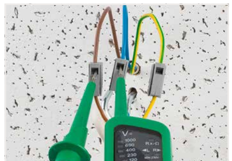
Prüfen in separater Prüfföffnung
