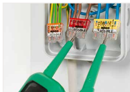
In Prüfföffnung auf der den Leitereinführungen entgegengesetzten Klemmenseite kann geprüft werden.
