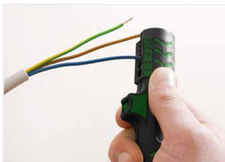
Abisolieren der Drahtisolation
