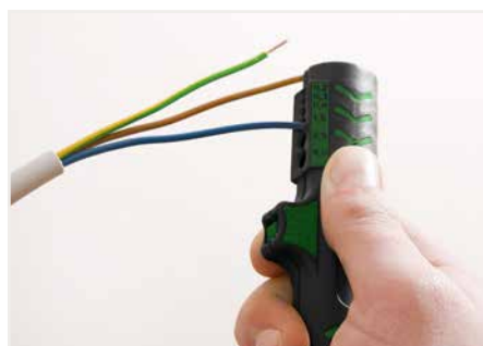
Abisolierung der Leiterisolation
