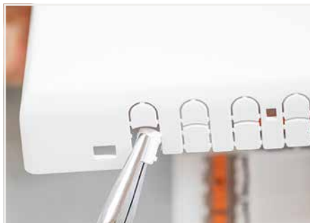
Abdeckung der Kabeleinführung aus dem Deckel ausbrechen.
