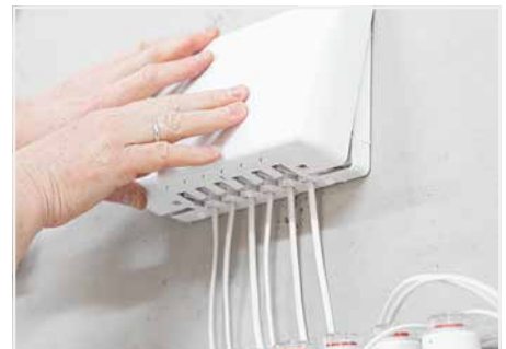
Deckel der Verbindungsdose aufrasten.
