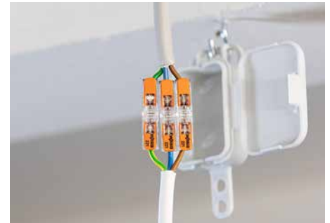
Leuchtenanschluss in Zwischendecken
