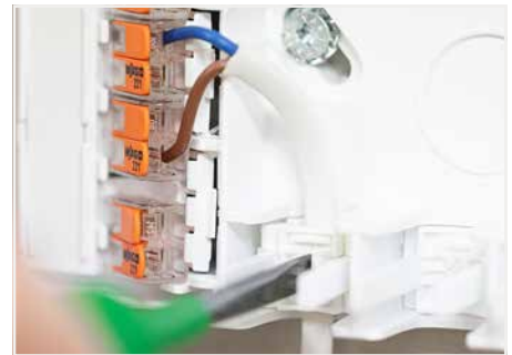
Kabel in die Zugentlastung einsetzen. Die einrastenden Zugentlastungen sind für Kabeldurchmesser von 4 bis 11 mm ausgelegt.
