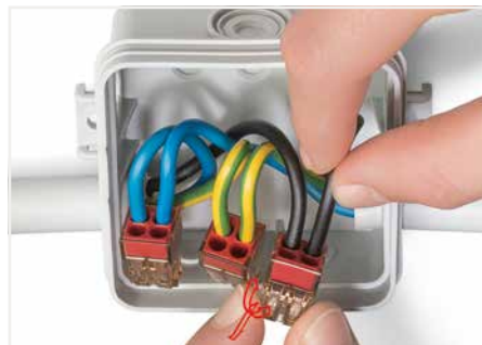
Lösen: Leiter festhalten, Klemme durch Hin- und Herdrehen mit leichtem Zug vom Leiter ziehen.
