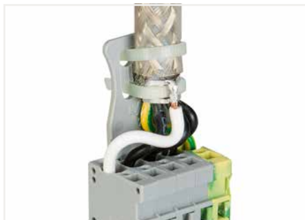
Mittels Kabelbinder den Schirmleiter und die Schirmübergabe (790-350) an der Zugentlastungsplatte befestigen.
