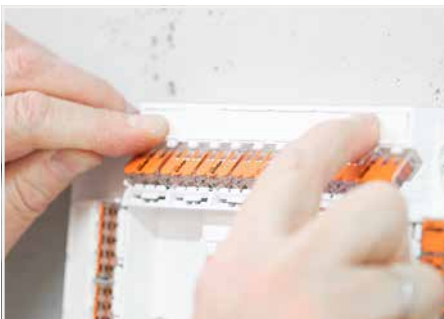
Beschriftungsstreifen in die Aufnahme einrasten.
