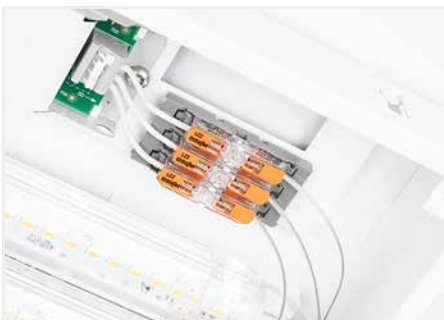
Mehrpolige, lagefixierte Verdrahtung einer Leuchte
