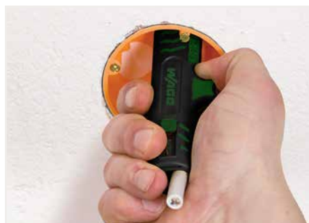
Abmanteln des Kabelmantels
