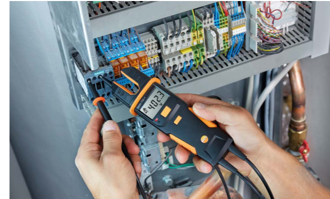
Spannungsprüfung an einer Wärmepumpe mit testo 755 .
