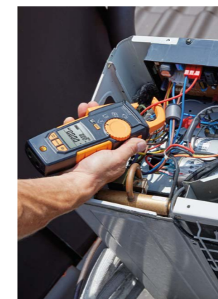
Einfädeln der Stromzange an einer Kälte-Außeneinheit.
