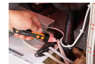
Erstprüfung der Spannungsversorgung an einem Verdichter.
