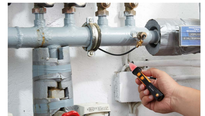
Spannungsüberprüfung an einer Verteilerdose mit testo 745 .
