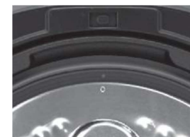
Správně instalované těsnění.
