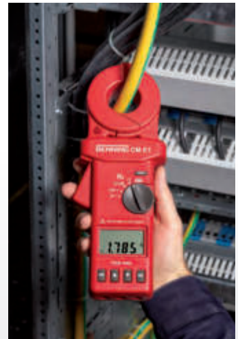
Messung des Betriebsresder einer Industrieverteilung
