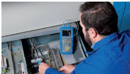
Ici, le technicien intervient sur le process d'une machine commandant des plateaux de composants.
