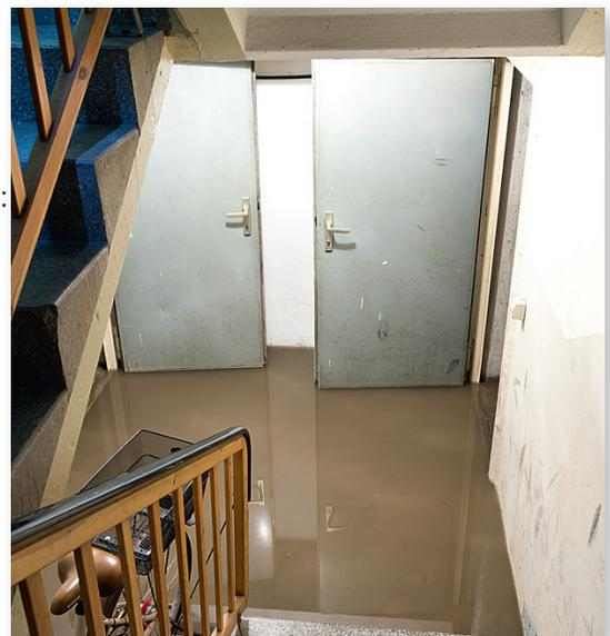
Daraufhin müssen beschädigte Bauelemente ausgebaut werden, die nicht mehr zu retten sind: Bodenbeläge, Trockenbauelemente, zerstörte Estriche, Türen, Technik...
