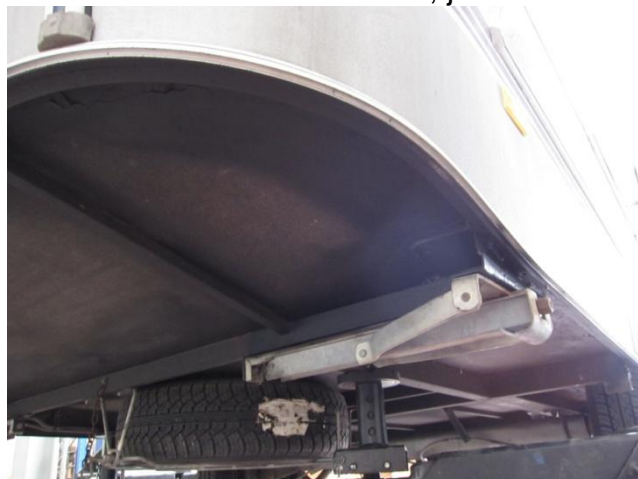
Wohnwagenboden: Hier massive Spanplatte, spärlich geschützt
