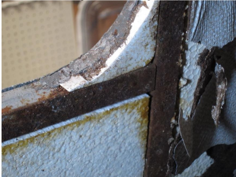
Isolation und Metallrahmen an älterem Wohnwagen
