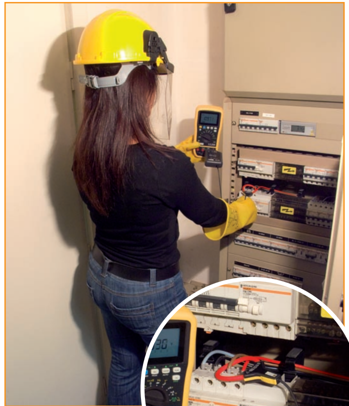
Die Flexibilität der Stromwandler ist besonders bei Messungen an Schalttafeln im Industrie- und Wohnbereich hilfreich.
