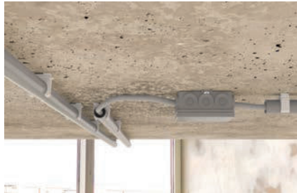
Befestigung von Kunststoff-Isolierrohren
