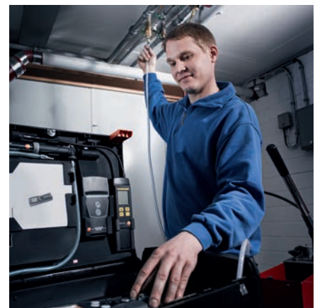
Trink- und Abwasserleitungsprüfung
