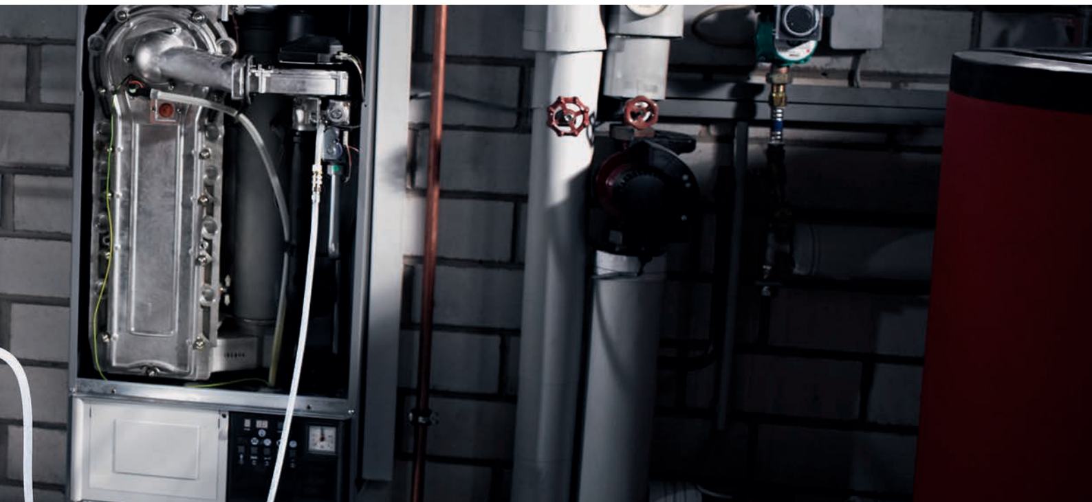
Automatische Gebrauchsfähigkeitsprüfung mit Einspeisevorrichtung
