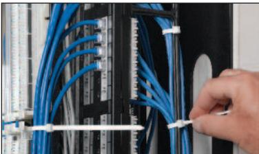
Bündeln Sie mit dem Kabelbinder mehrere Kabel. Greifen Sie das abstehende Binderende, bewegen Sie es hin und her und drehen es, bis es abreißt. Es entstehen keine scharfen Kanten, wodurch Sie sich oder die Kabel verletzen könnten.
