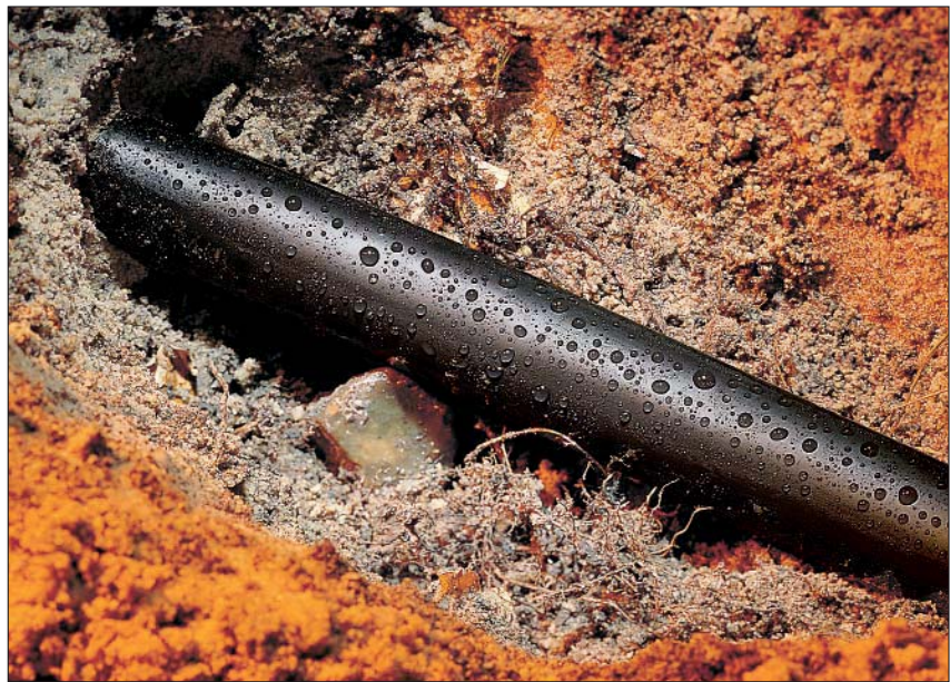
TREDUX HA47 – Einsatz im Erdreich.
