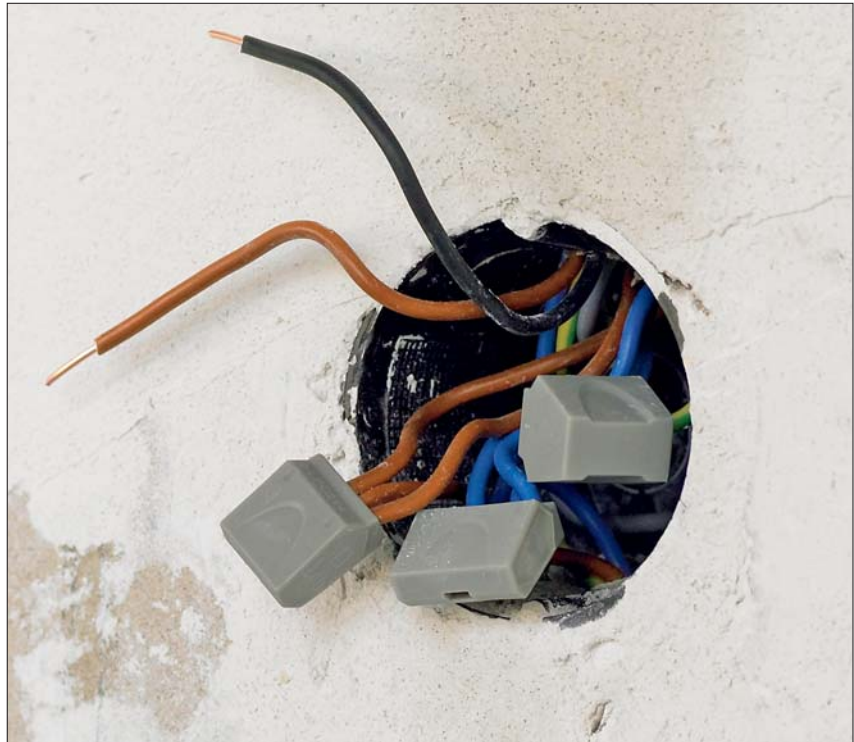
Durch die kompakte Bauform eignet sich HelaCon Easy besonders bei engen Platzverhältnissen.
