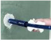
Die 3M Warm Schrumpf-Mauerdurchführung vom Typ WMD dient zur Abdichtung von Fernmeldekabeln in Mauer- und Wanddurchführungen.
