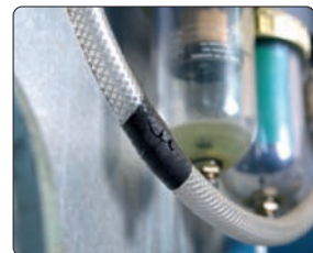
Abdichten eines Druckluftschlauches
