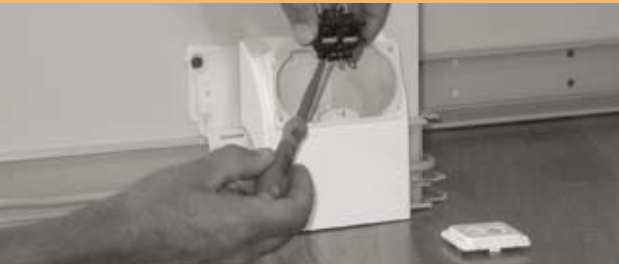
Schritte bis Bild 17, Kabel durch Oberteil-Öffnung ziehen und am Geräteeinsatz anschließen
