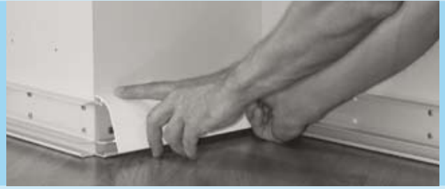
Deckprofil einhängen (erst oben, dann unten)
