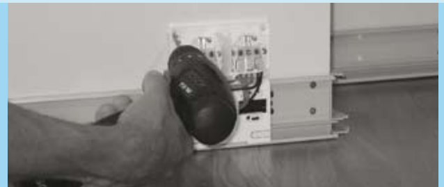
Bohrungen herstellen, Dübel dahinter einsetzen und absaugen
