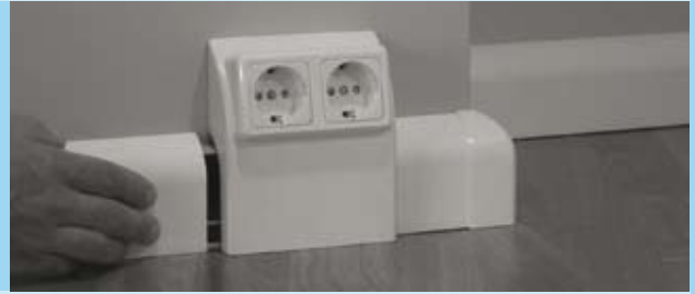
Sockelleiste ablängen und einschieben
