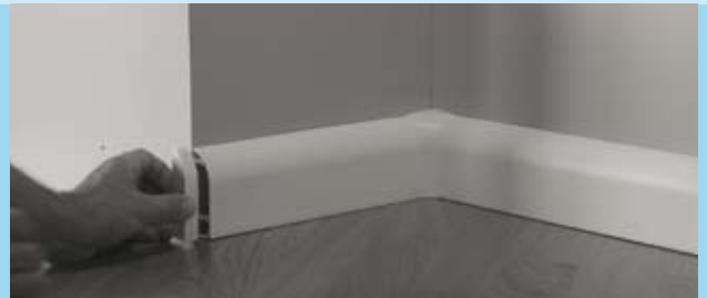
Endstück montieren - FERTIG!
