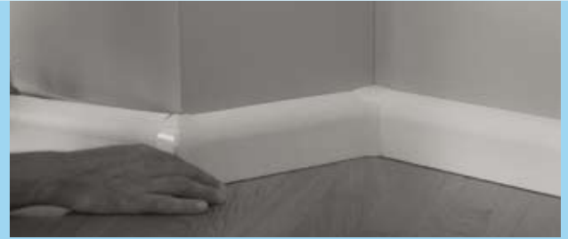
Außenecke montieren
