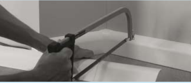
Deckprofil passend messen & ablängen
