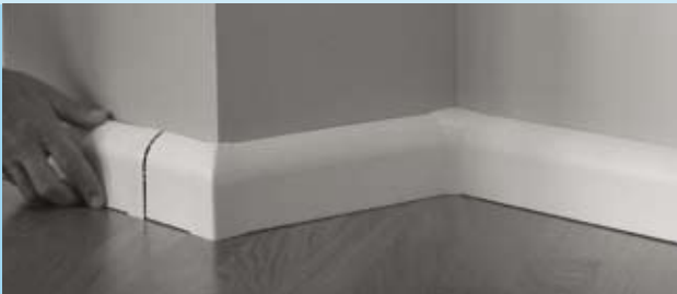
Stoßverbinder montieren
