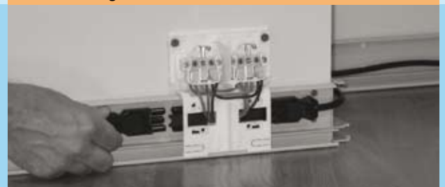
Steckverbindungen herstellen & Kabel verlegen
