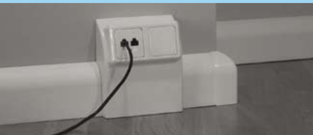
Äußeren Blendrahmen aufrasten, Sockelleiste fertigstellen FERTIG!
