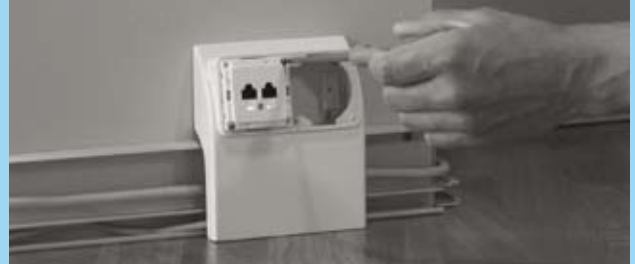
Oberteil aufsetzen, Kappe mit Geräteeinsatz verschrauben und am Oberteil verschrauben
