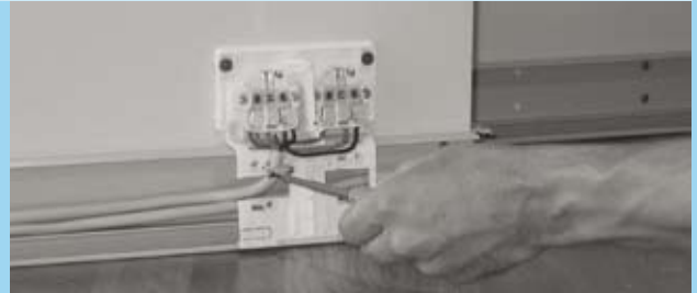
Zugentlastung aufschrauben weiter ab Bild 19 bis 22
