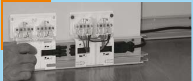
TIPP: Anreihung zweier Steckdosencontainer mit Steckverbindertechnik, Kupplung Art.-Nr. 72902 verwenden
