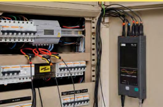
Mit der DataView®-Software kann sich der Benutzer automatisch Berichte, Energiebilanzen und Verbrauchskurven erstellen lassen, um damit schnell Verbrauchsspitzen zu erkennen. So lassen sich z.B. Überschreitungen einer vertraglich vereinbarten Abnahmemenge vermeiden, die zu Aufschlägen auf die Energierechnung führen.
