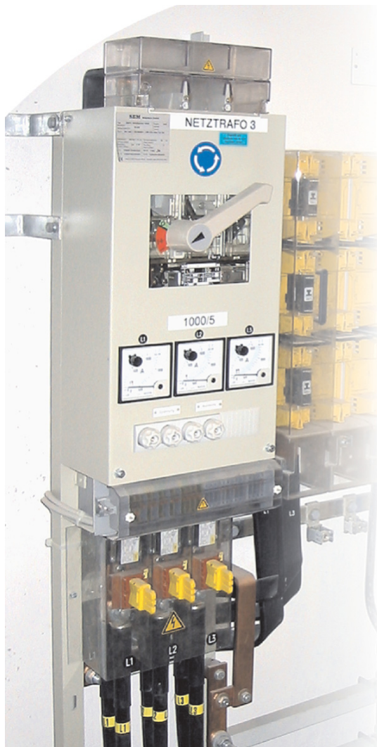
Beispiel: Hausanschlusskasten und Beispiele von Messzubehör für CAT IV.
