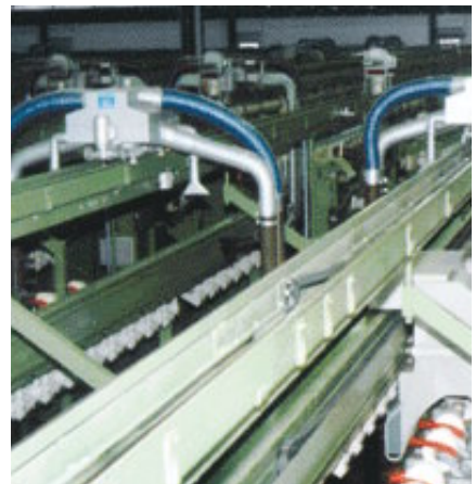
Anwendung bei langen Verfahwegen bis zu 40 m möglich - Serie 10 hier in einer Textilmaschine
