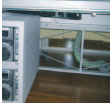
Geordnete Kabelführung und schönes Design in einem Fernsehstudio mit Triflex® R
