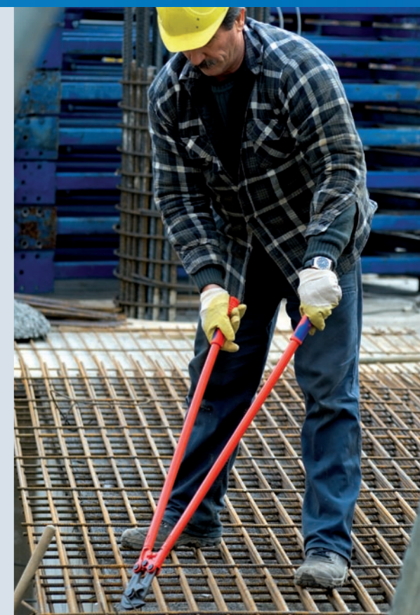
Die besondere Kopfform des Mattenschneiders 71 82 950 ermöglicht das Schneiden flachliegender Baustähle
