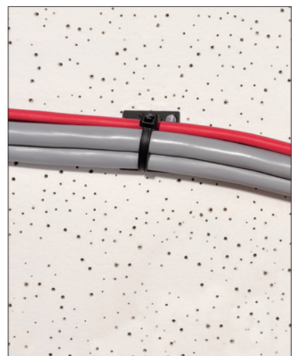
Ist die Installation fertiggestellt, wird der Q-tie wie üblich angezogen und abgebunden.
