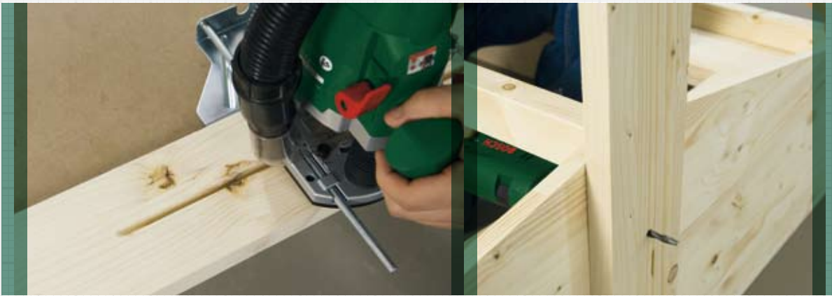
5. Dachträger vorbereiten und mit dem Sandkasten verbinden
