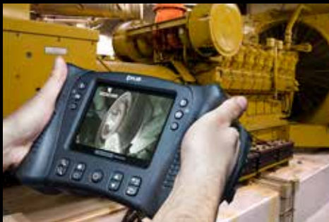
Inspektion eines Generators
