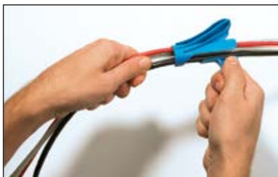
Kabelbündel seitlich in das Aufziehwerkzeug legen.
