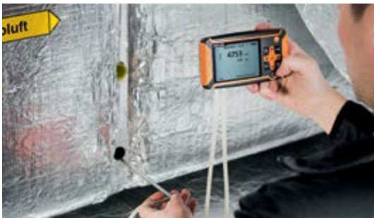
Staurohrmessung im Kanal.
