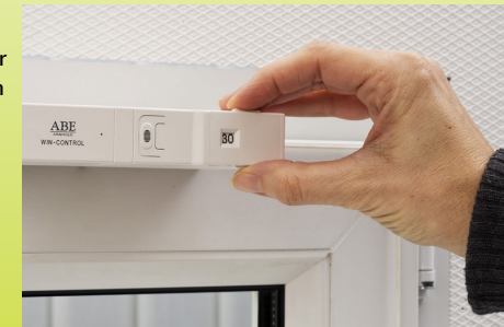
Abb. 33: Einstellung der Zeitscheibe im Uhrzeigersinn
