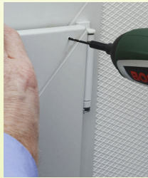
Abb. 15: Vorbohren für die Befestigung der Umlenk-Rolle
