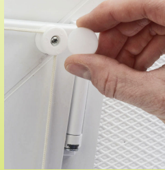
Abb. 17/18: Entriegelungsschnur über die Umlenk-rolle legen und deren Abdeckung darauf setzen
