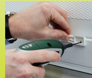
Abb. 2: Löcher am Fensterflügel vorbohren
