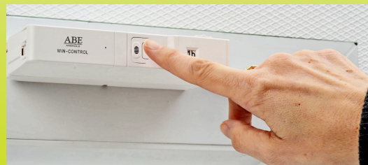
Abb. 35: Betätigung der Schließaste (A5)
