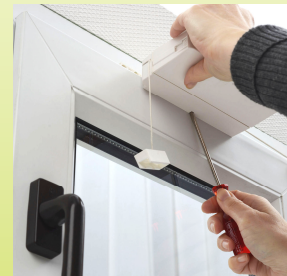
Abb. 43: Einrastung lösen
