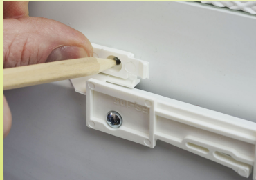
Abb. 5: Position der Schrauben für Fensterrahmen-Halterung markieren
