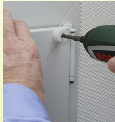
Abb. 16: Anschrauben der Umlenk-Rolle
