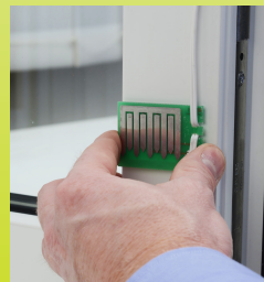
Abb. 25: Regensensor befestigen
