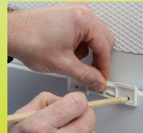
Abb. 1: Fensterflügel-Halterung (C) anlegen und Bohrlöcher anzeichnen
