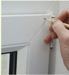
Abb. 14: Position der Bohrung für die Umlenk-Rolle markieren
