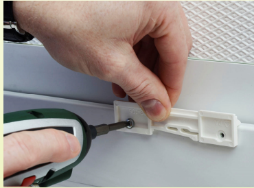
Abb. 3: Schrauben am Fensterflügel
