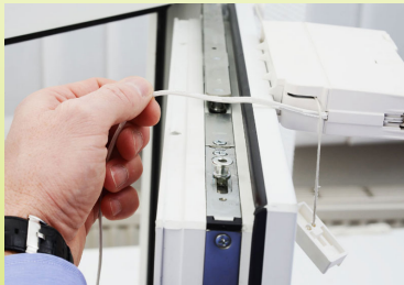
Abb. 23: Führen des Kabels nach außen
