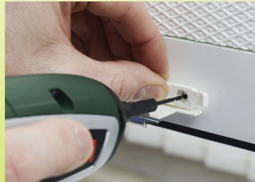
Abb. 6: Löcher am Fensterrahmen vorbohren
