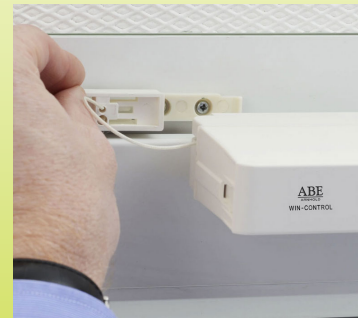
Abb. 36: Entfernen des Clip (A1)
