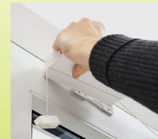
Abb. 44: Fensterschließer abziehen
