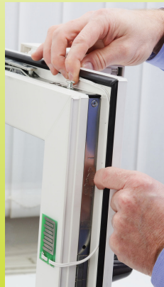
Abb. 31: Kabel seitwärts legen und mit Klebeband fixieren
