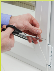
Abb. 19: Kürzen der Entriegelungsschnur auf die gewünschte Länge
