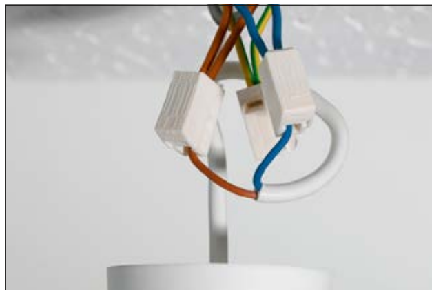
Schnelle Installation von Leuchten mit HelaCon Lux.
