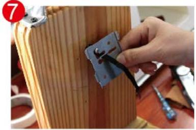
Ziehen Sie mit der Schraube die Montageplatte an.
