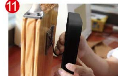
Schützen Sie das Kabel, bevor Sie den Sender montieren.
