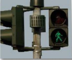
Ampelanlagen kennst du sicherlich in verschiedenen Ausführungen. Fußgängerampeln oder ganzen Kreuzungsanlagen begegnest du fast täglich, so dass das Prinzip für dich nichts Neues mehr ist. Einfach ausgedrückt, Lampen werden in einer bestimmten Reihenfolge ein- und ausgeschaltet.
