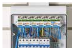
PE- und N-Trennklemme in FIXCONNECT®- Steckklemmentechnik
