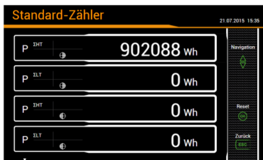
Zähler mit Tarif- und Quadranten- Information
