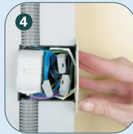
4 Einbau des Aktors in Schalter- oder Installationsdose mit Abdeckung
