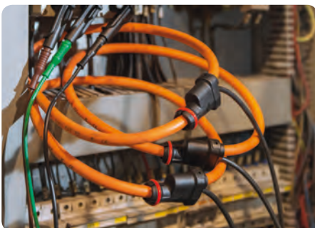
Messung Einsatz der flexiblen Stromwandler
