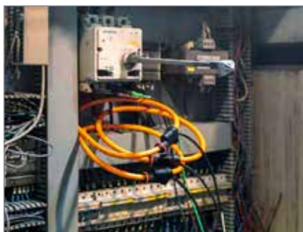
Messung Einsatz der flexiblen Stromwandler
