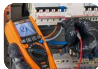
Drehfeldrichtung mit 1-phasiger Methode.
