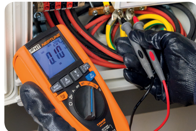
Durchgangsprüfung von Schutzleitern.
