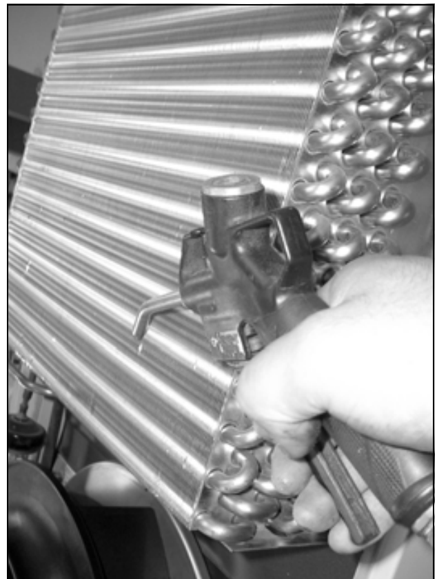
Abb. 75: Wärmetauschregister und Kompressorraum mit Druckluft ausblasen (2)
